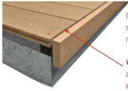
Die Abschlussleiste mit der Terrassenbauschraube oder verdeckt mit Dübel direkt mit der Konstruktionsleiste verschrauben.
