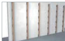
Alleen verticaal regelwerk = installatie CSP horizontaal.
