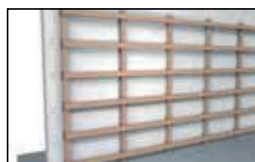
Horizontaal regelwerk bovenop verticaal regelwerk = installatie CSP verticaal.
